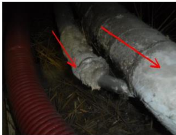
leidingsisolatie achter knieschot en tussen rieten kapconstructie
